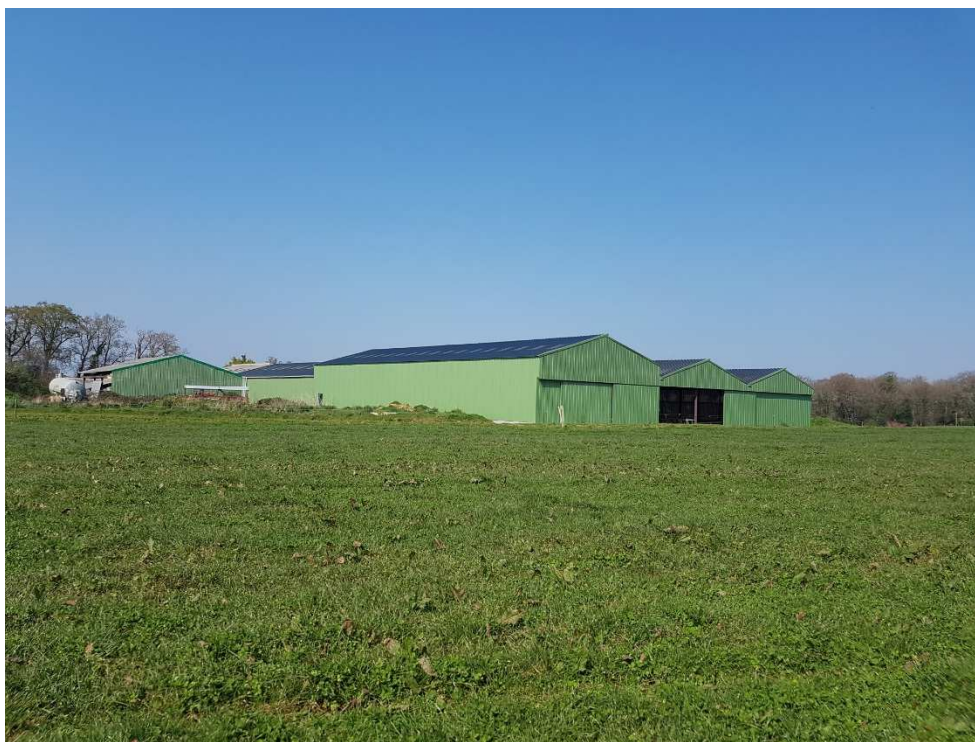
Photos n°3: Vue de l'élevage coté Sud Ouest
